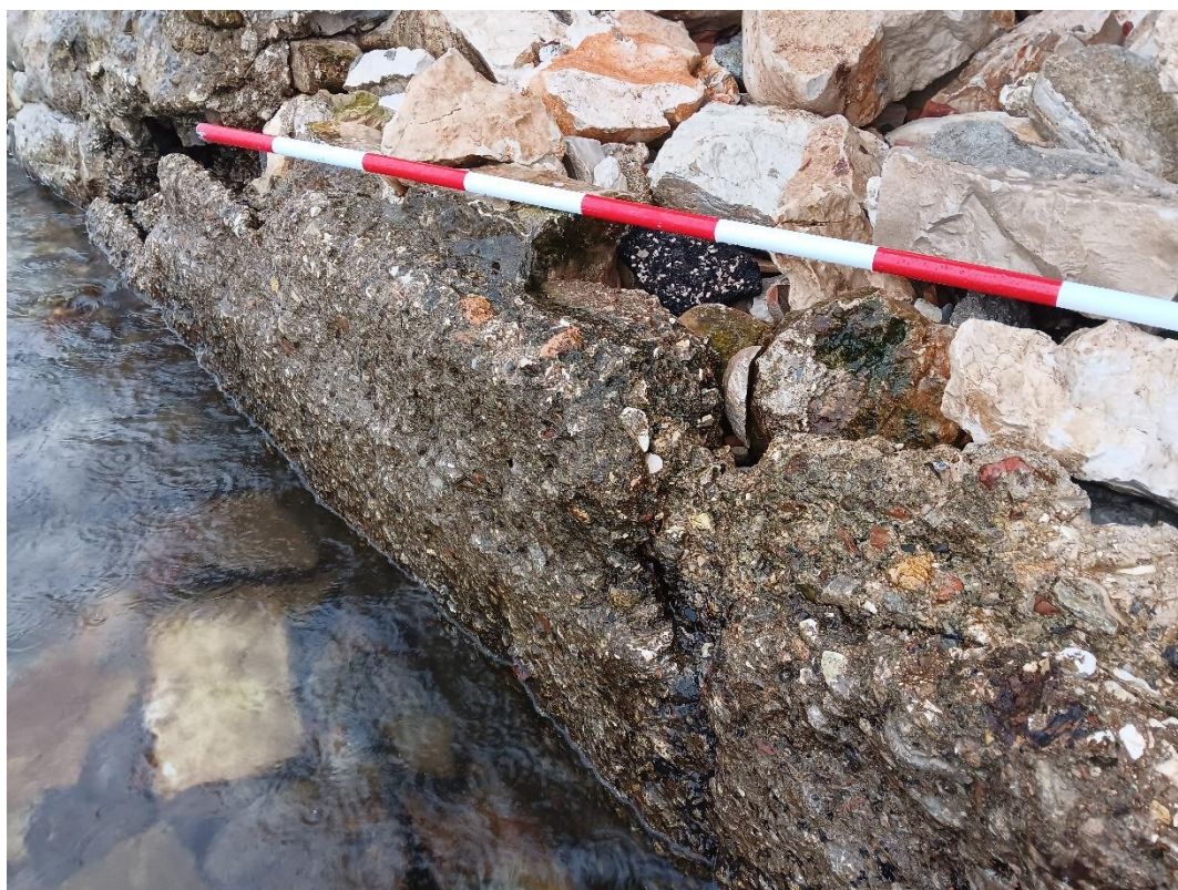
Slika 14. Pogled na temelj oštećenog obalnog zida
